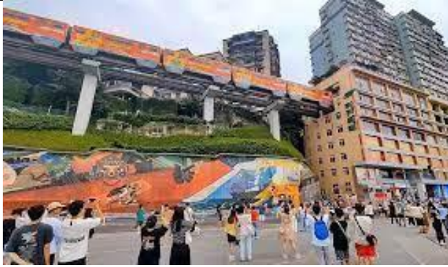
Tàu điện xuyên tòa nhà 19 tầng ở Trùng Khánh
